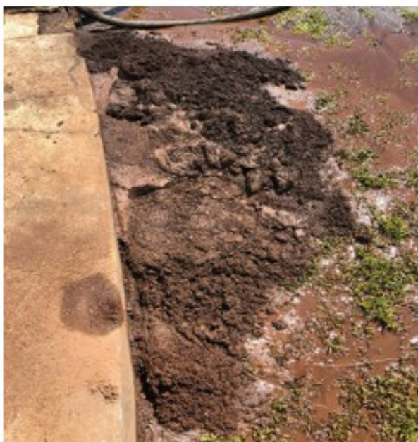
Figura 11 – Sujidade no interior do tanque de etanol.
